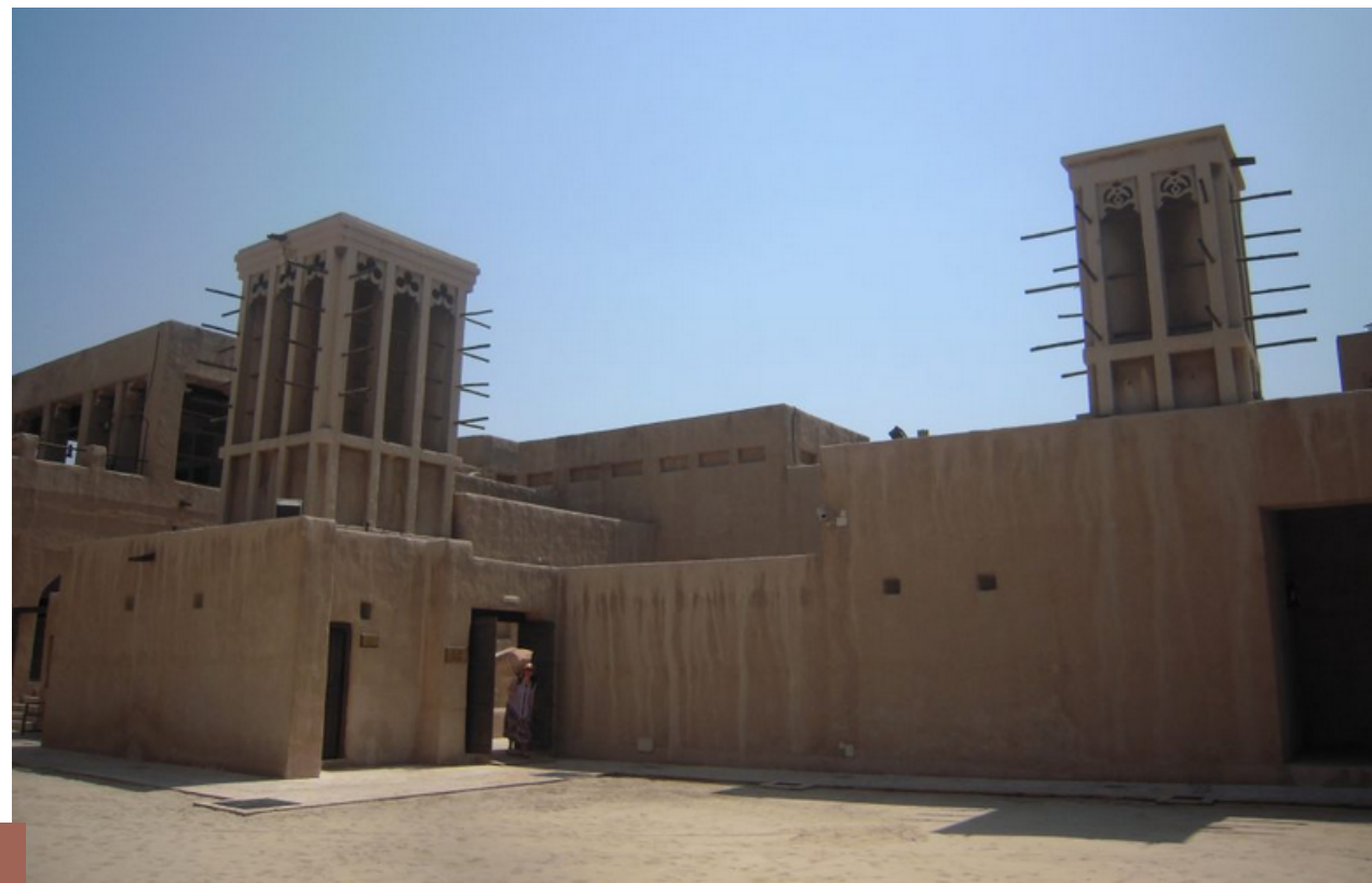
Tour de vent dans chaque pièce de vie Emirats Arabes Unis
