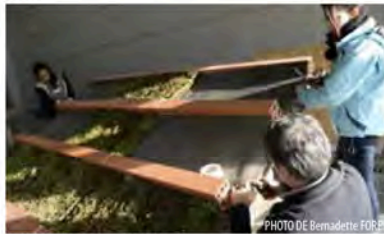
MISE EN PLACE DE GEOTEXTILE ET SEDUM
