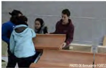
MISE EN PLACE DES TUILES
