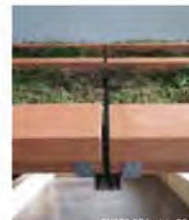
JOINT ENTRE LES TUILES
