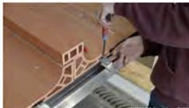
FIXATION DES TUILES AVEC LA PARTIE HAUTE DU CRAPAUD
