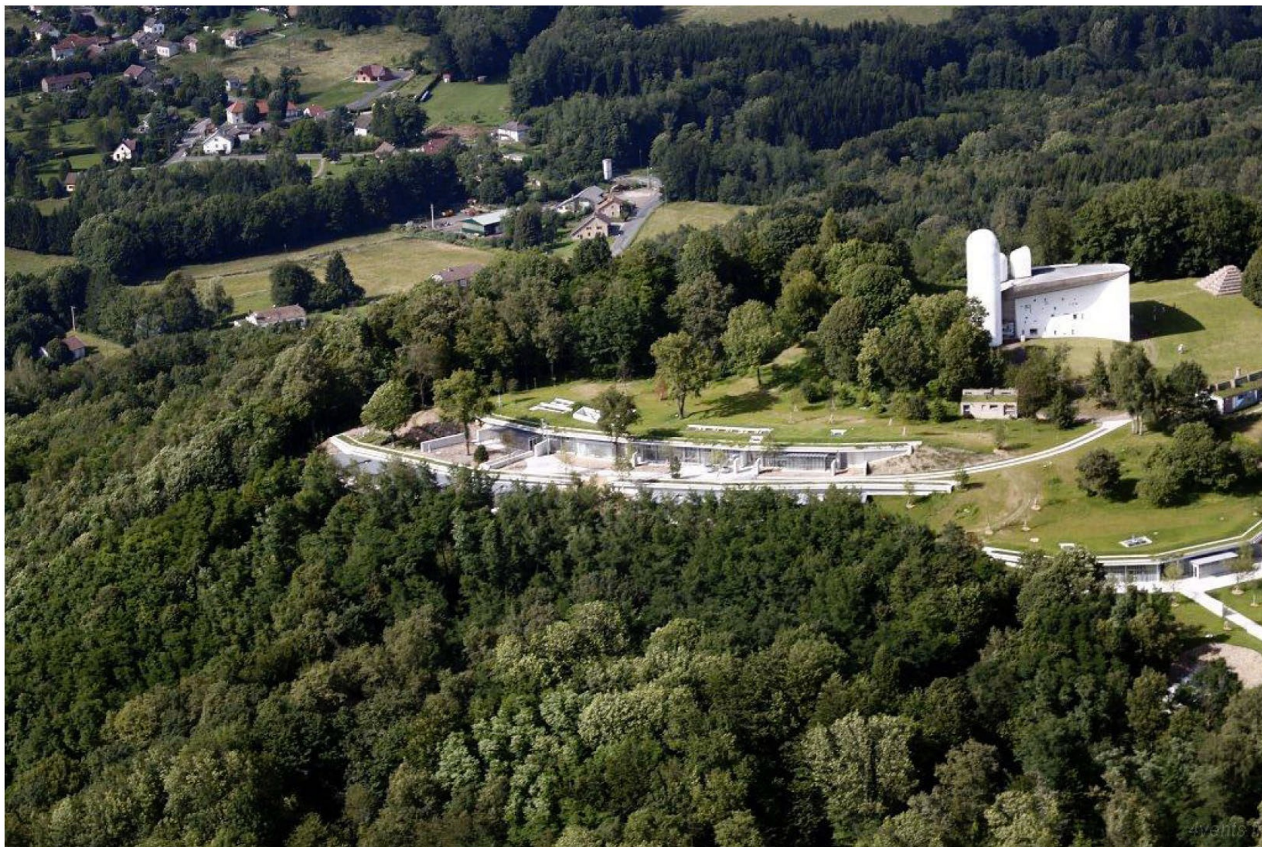
ACCUEIL DES VISITEURS ET MONASTERE DE SAINTE CLAIRE, RONCHAMP RENZO PIANO BUILDING WORKSHOP + ATELIER CORAJOU 2006-2011
