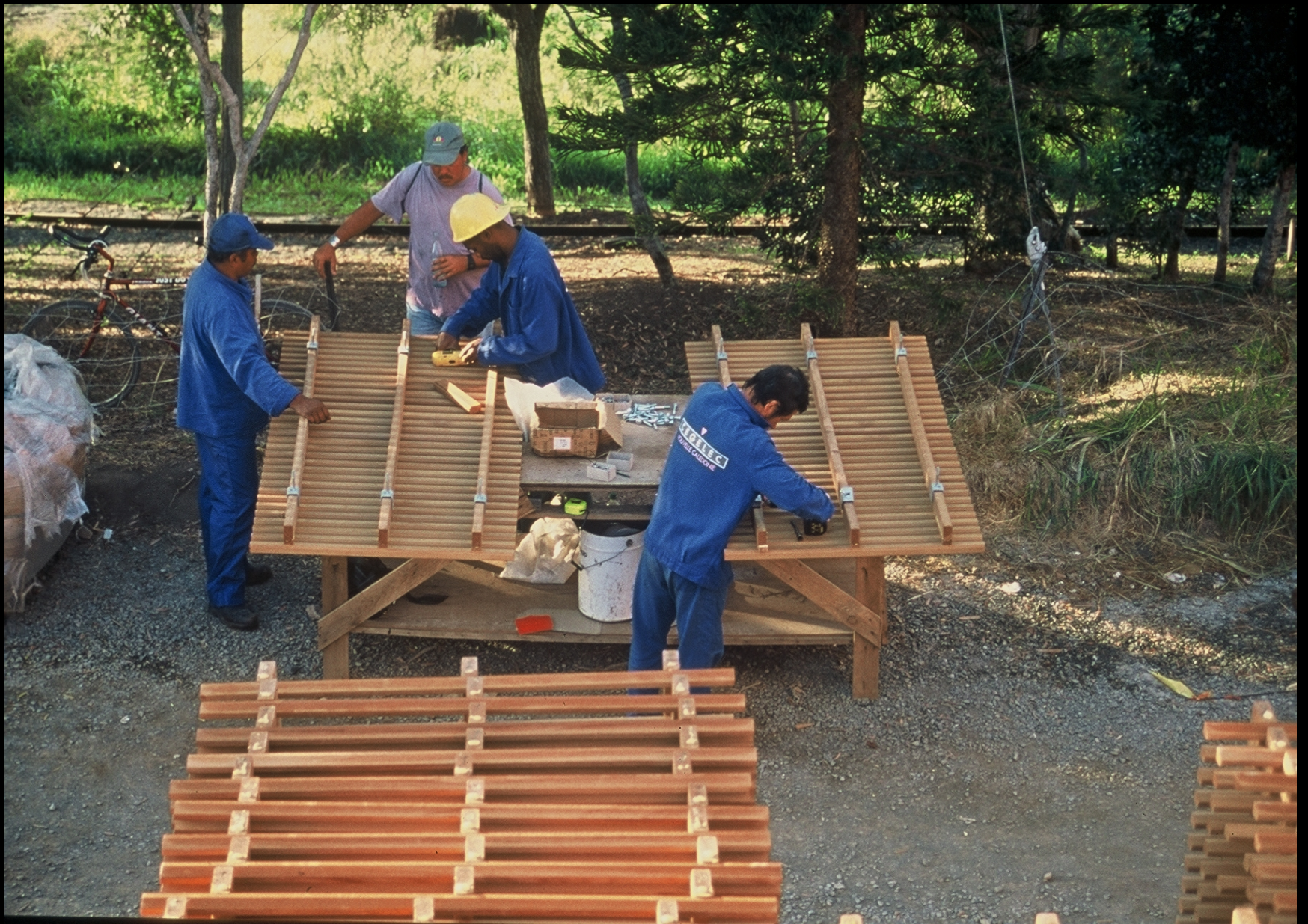
LES PANNEAUX BOIS A DENSITÉ VARIABLE AVEC LA VENTILATION
