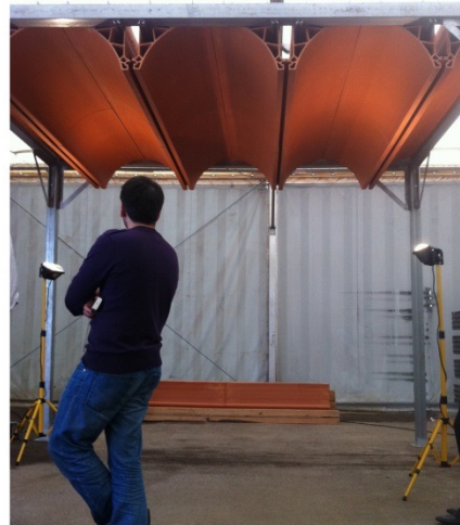
OPTION (B) / 3 BLOCS FILANTS + 2 PROFILS METALLIQUES DE LIASON DES BLOCS
