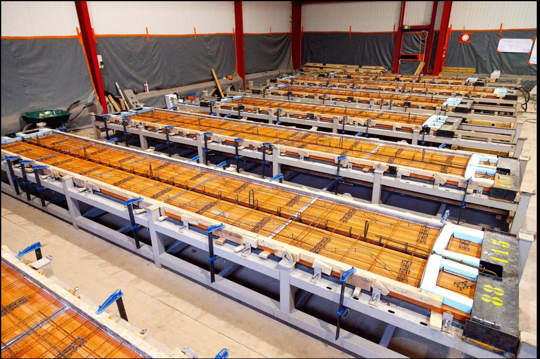
PRÉFABRICATION IN SITU A AMIENS
